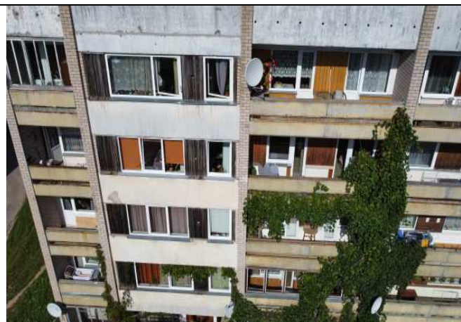
Attēls Nr.1, Ēkas dienvidu fasāde
